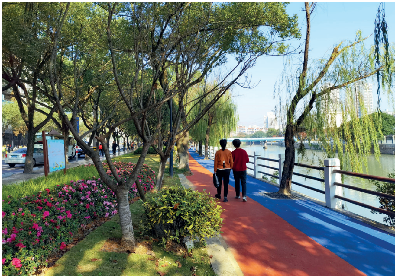
西山东路道路综合整治成效
