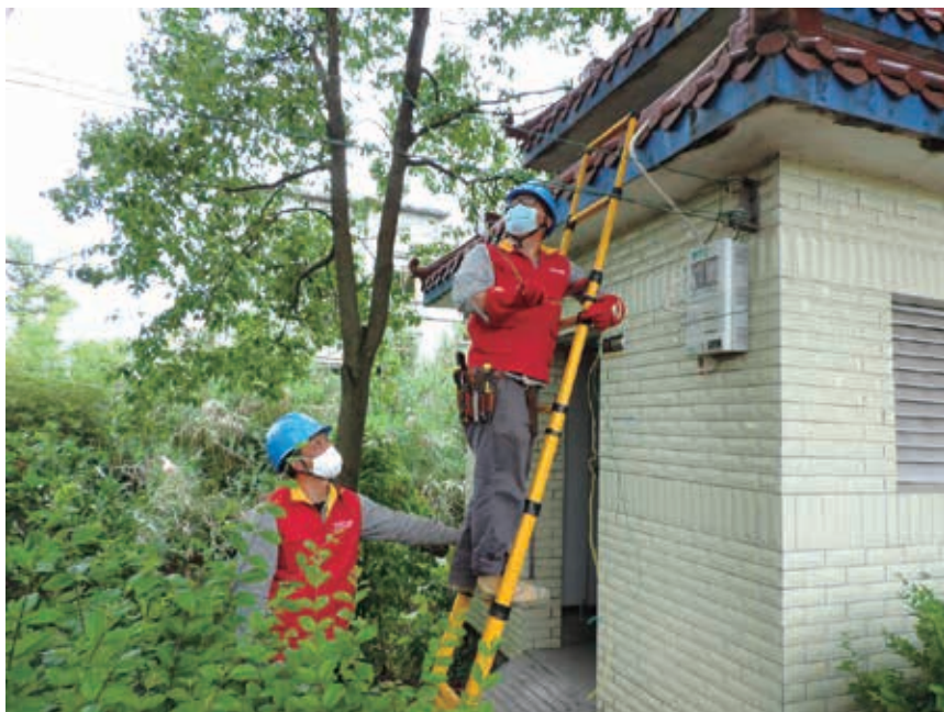
龙湾供电分局电力人员在整理空中管线
